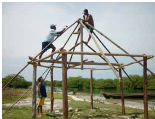
Bau des neuen Besucherzentrums in Dainyaa
