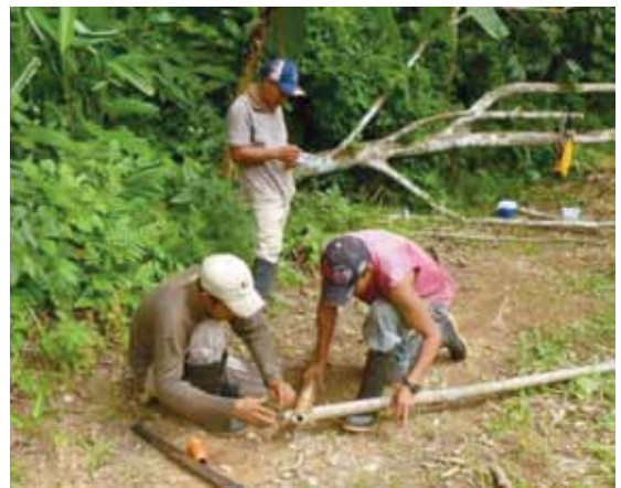
Aufbau eines A-Rahmens in Uggubseni
