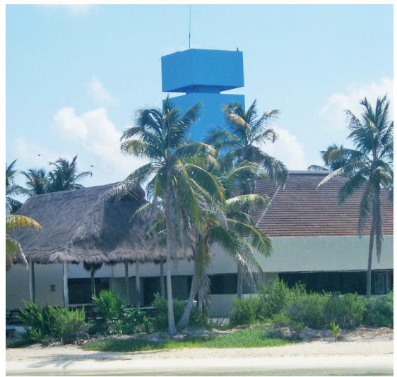
Vom Aussichtsturm auf Isla Contoy läßt sich die ganze Insel überblicken. Wegen der maroden Treppe ist der Zugang allerdings noch gesperrt.
