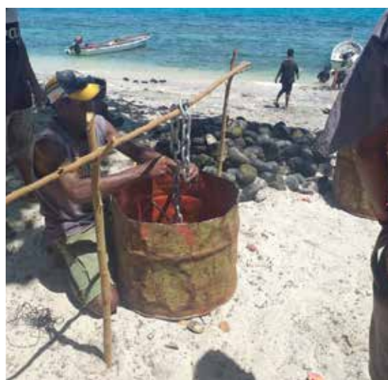
Die Grundgewichte für die Mooringbojen wurden aus Beton direkt am Strand hergestellt.
