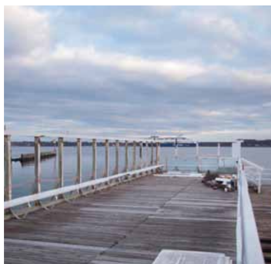
Die Windschutzwand wurde komplett abgebaut und bis zur Eröffnung im Juni total saniert wieder aufgebaut.
