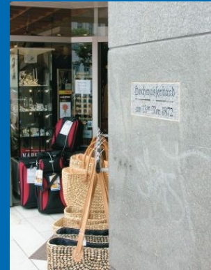
Abbildung L4: Hochwassermarken in Eckernförde Foto (c) unbekannt
